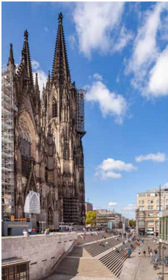
Die Lage der Baustelle am Kölner Dom: Die Treppe verbindet Domplatte und Bahnhofsvorplatz. Täglich frequentieren ca. 100.000 Passanten die Treppe.
