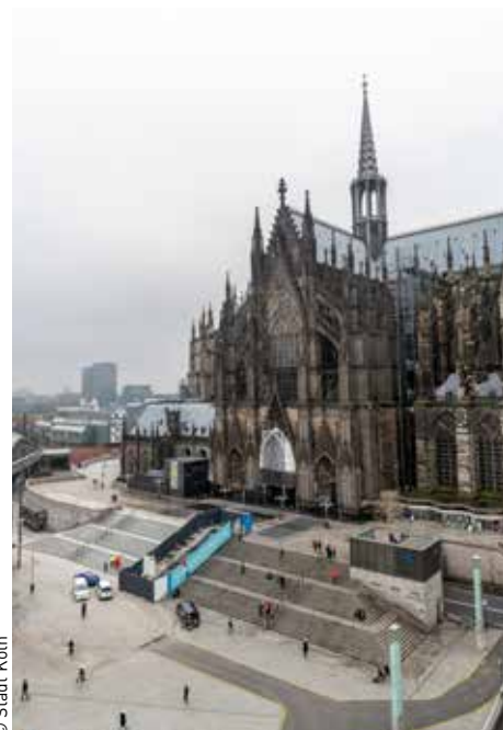
Nach Vollendung der ersten Baustufe wurde der Baubetrieb in der „nährischen Zeit“ ausgesetzt. Im folgenden Frühjahr wurde dann die rechte Seite der Domtreppe in Angriff genommen.
