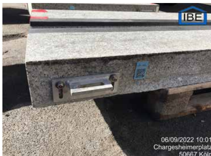
Alle Treppenstufen wurde mit einem individuellen QR-Code versehen, um jeden Bearbeitungsschritt exakt nachvollziehen zu können.
