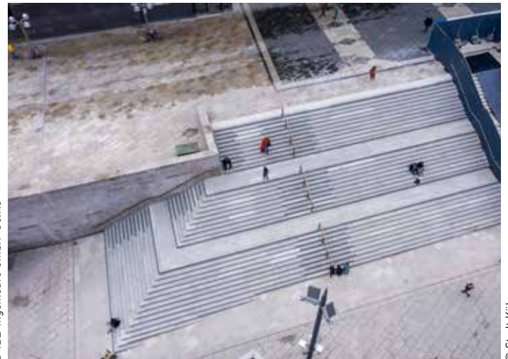
Auf Wunsch des Bauherrn sollten Verbesserungen für sehbehinderte Menschen vorgenommen werden; dazu sollten um die Treppenläufe Kontraststreifen in einem Teil der Stufen eingearbeitet werden.
